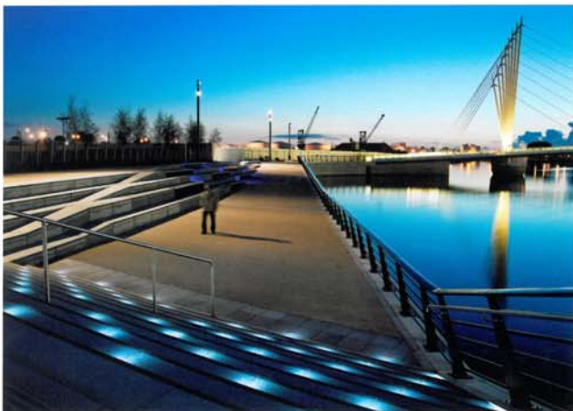
完善的照明系统
